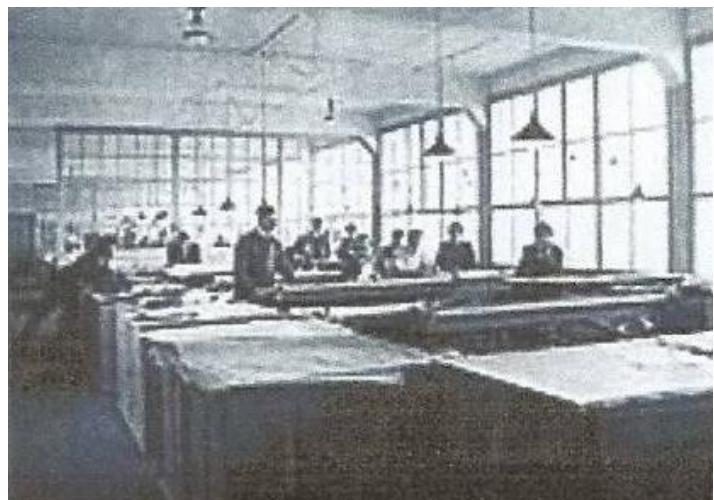
ESCRITÓRIO DE ENGENHARIA DA FÁBRICA
